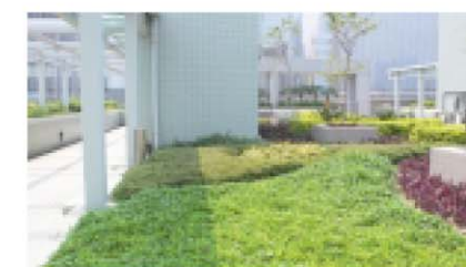
圖 29 中環 2 號碼頭的天台花園 Rooftop garden of Pier 2, Central
